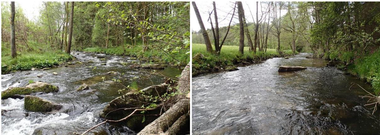
Abb. 23 *Durchbruchsstrecke der Teisnach: Abschnitt mit natürlicher Ausprägung (links) und ein Bereich, in dem die natürlich im Gewässerbett vorhandenen Steine als Ufersicherung verwendet wurden und dadurch monotone Abflussverhältnisse herrschen (rechts).*
