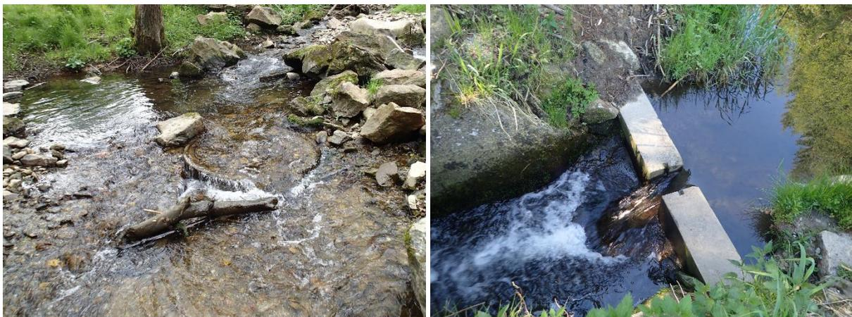
Abb. 11 *Über weite Bereiche nicht so schlecht funktionierende Aufstiegshilfe mittels Schachtringen im Teisnach-Mittellauf weist einige nur flach überströmte und daher nahezu unpassierbare Abschnitte auf (links). Im Teisnach-Oberlauf wird eine Fischwanderhilfe über einen ungünstig dotierten und damit schwer durchwanderbaren Schlitz mit Wasser versorgt (rechts).*
