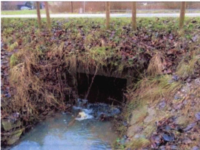
Bild 5 Verrohrung mit Absturz am Federlehner Bach
