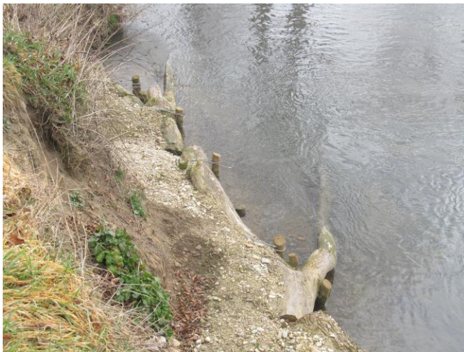
Bild 9: Einbau von Totholz an der Rott im Bereich Zellhub
