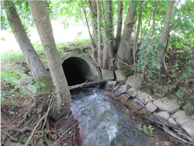
Bild 5 Durchlass am Kollbachüberleiter, Fluss-km 0,300 bei Ehrnstorf
