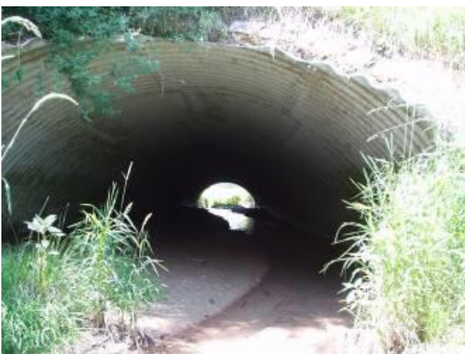
Bild 6: Breiter Durchlass mit Uferstreifen im Mittelwasserbereich am Saussbach bei Annathal; Lkr FRG.
